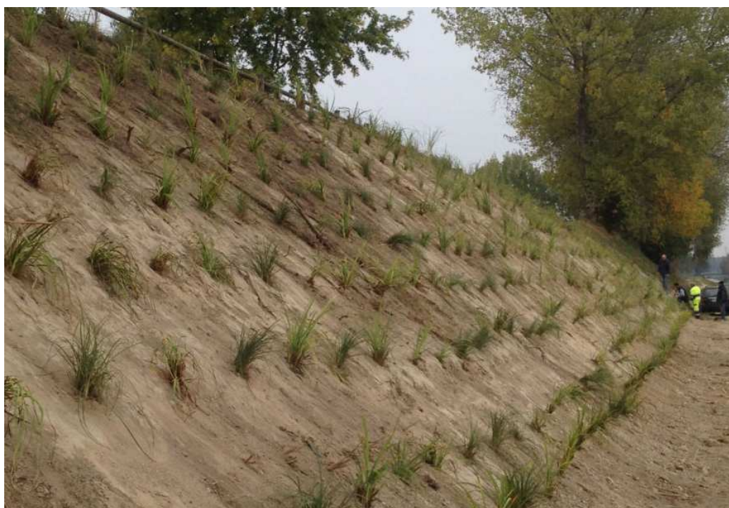
Esempio di applicazione su scarpata delle Chiodature Vegetali
